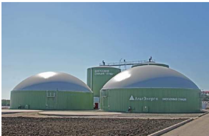
Рис. 4.14. Биогазовая станция «Лучки»
